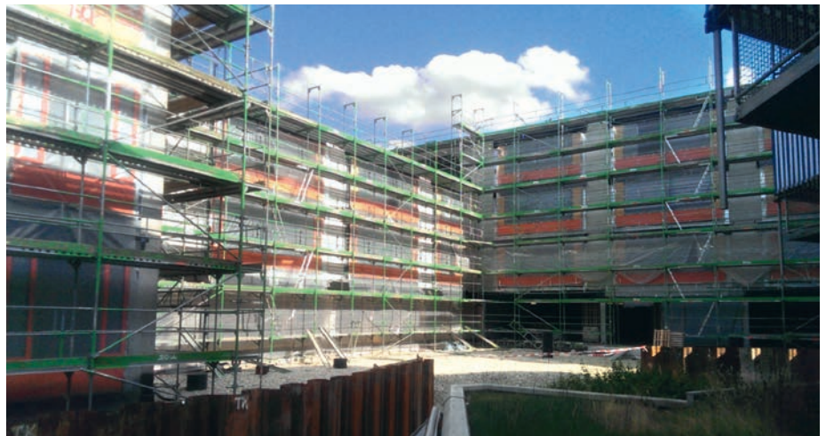
Der Neubau der Realschule nimmt Gestalt an
