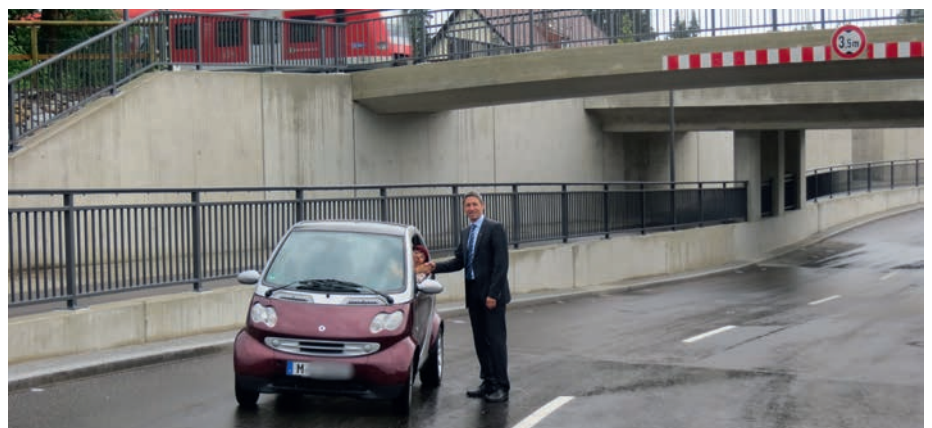
Der Verkehr rollt. Hannelore Widmann fährt als erste durch die Straßenunterführung
